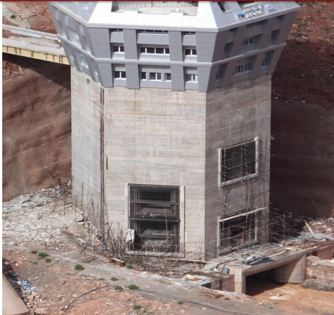
برج آبگیر سد ونیار
