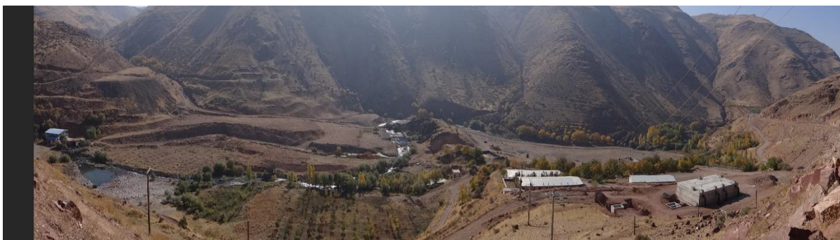
تصاویر سوله های پایین دست سد (برای احداث استراحتگاه و رستوران)*
