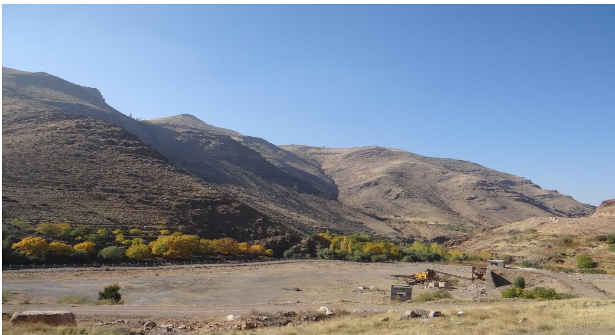
تصویر پایین دست سد برای احداث آلا چیق و سایر تاسیسات
